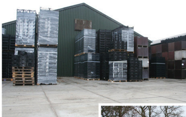
Industrieplaten gebruikt voor een opslagruimte
